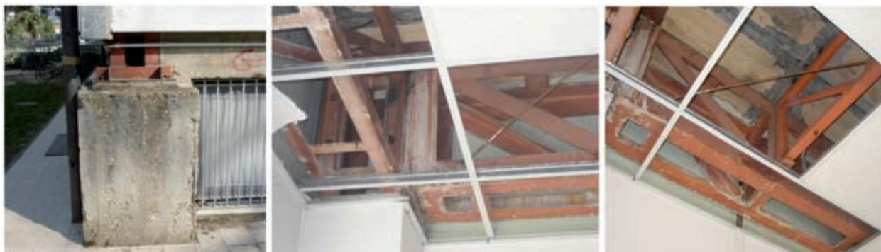
Figura 8 - Attacco pilastro. Figura 9 - Nodo Trave I° ordine - Pilastro. Figura 10 - Nodo Trave I°- II° ordine
